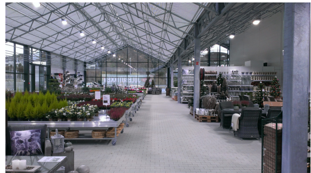
FL100 Sunlight installation i et havecenter i Norge
